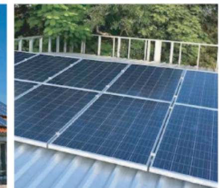
3. Khung lắp đặt trên mái tole
