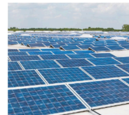
1. Khung lắp đặt trên mái bằng
