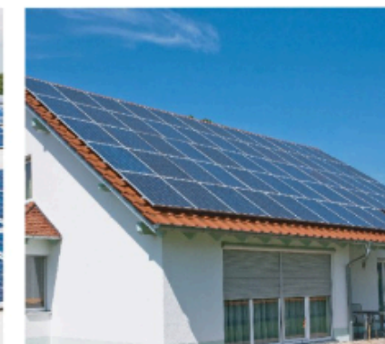
2. Khung lắp đặt trên mái ngói
